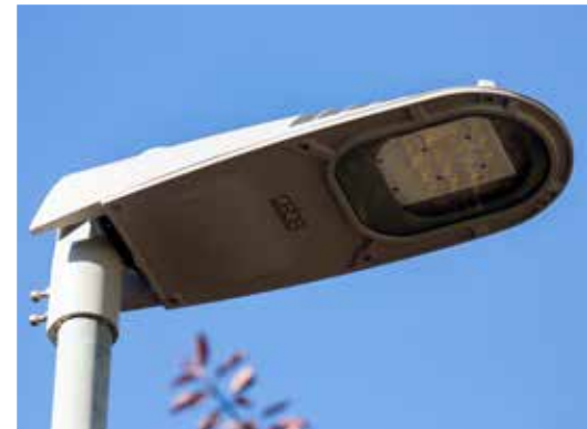
I år var det dags för Skelleftehamn att få ny belysning och valet föll på Cebe Belysning och armaturen Motion Street.
