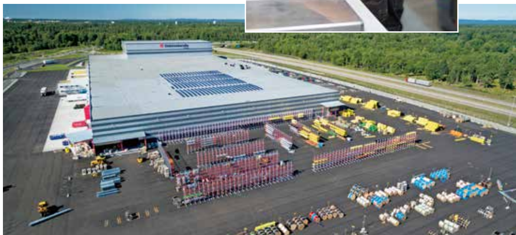
Elektroskandias logistikcenter i Örebro är hjärtat i verksamheten och därför vidtogs extra rigorösa åtgärder för att skydda det när coronapandemin bröt ut.
